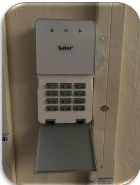
Obr. nová klávesnica elektrického zabezpečovacieho systému
