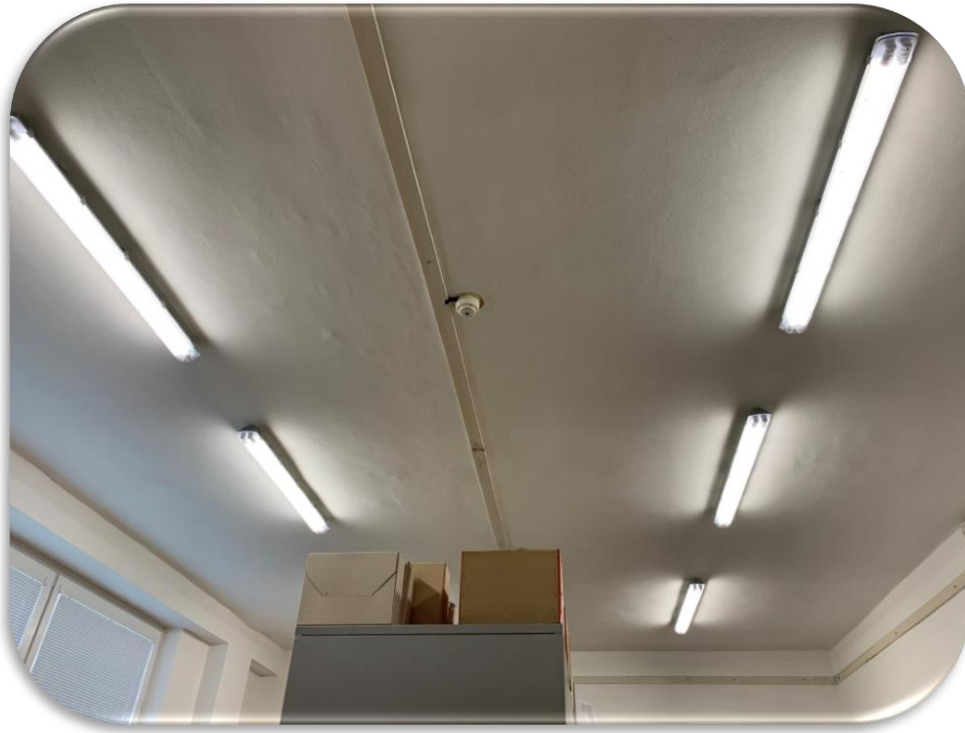
Obr. nové osvetlenie a hlásič EPS v mapárni
