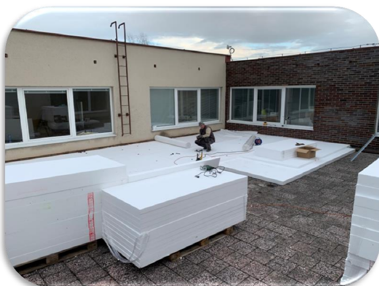
Rekonštrukcia zatekajúcej terasy sídelného archívu
