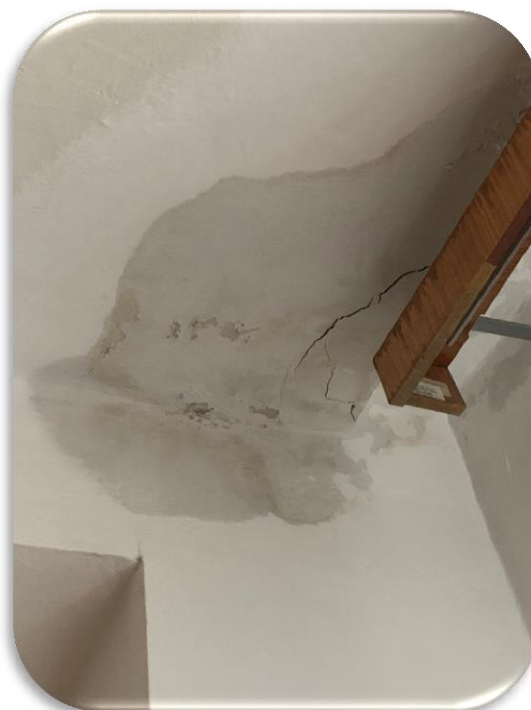
Zatekanie do bádateľne sídelného archívu
