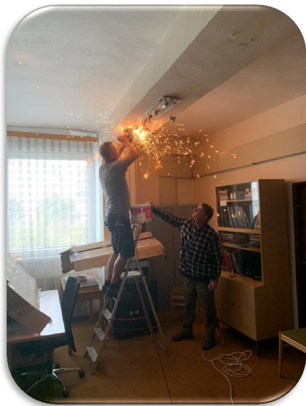
Výmena osvetlenia v bádateľni sídelného archívu
