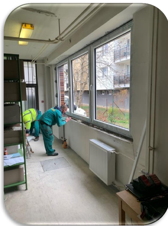
Výmena okna pri zadnom východe sídelného archívu
