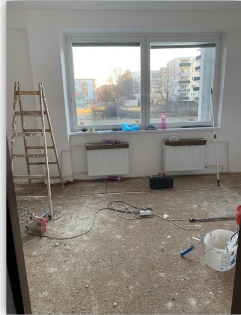
Obr. 4: Rekonštrukcia jednej z kancelárii
