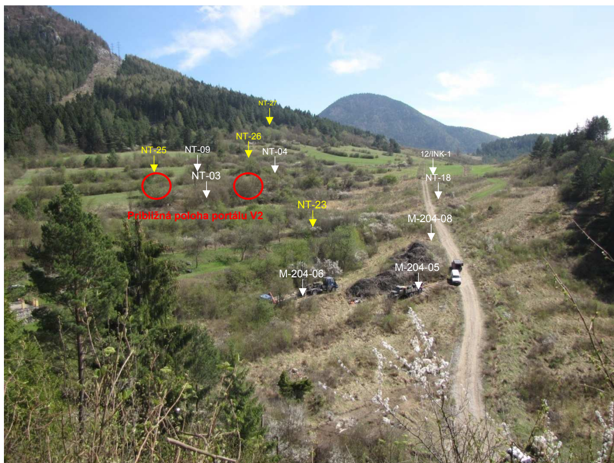
Obrázok 13 Pohľad na portálovú oblasť a oblasť mosta 204 zo západu. V popredí mostík cez Kamenný potok.
