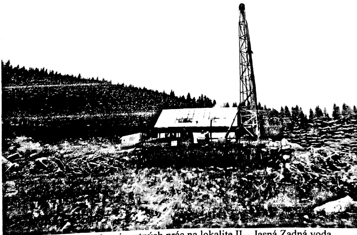
Obr.č2: Vykonávanie vrtných prác na lokalite II – Jasná Zadná voda
