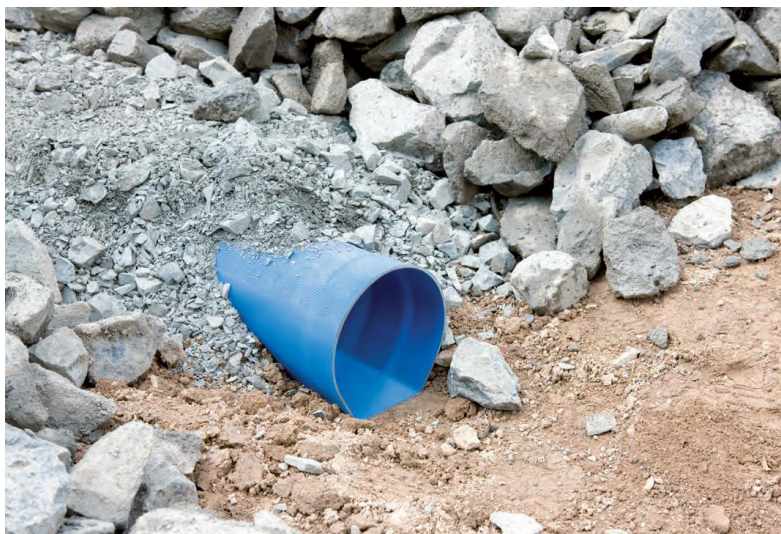
Obr.č.5. Tunelový tvar drenážneho potrubia z PVC s obsypom z drveného netriedeného miestneho kameniva
