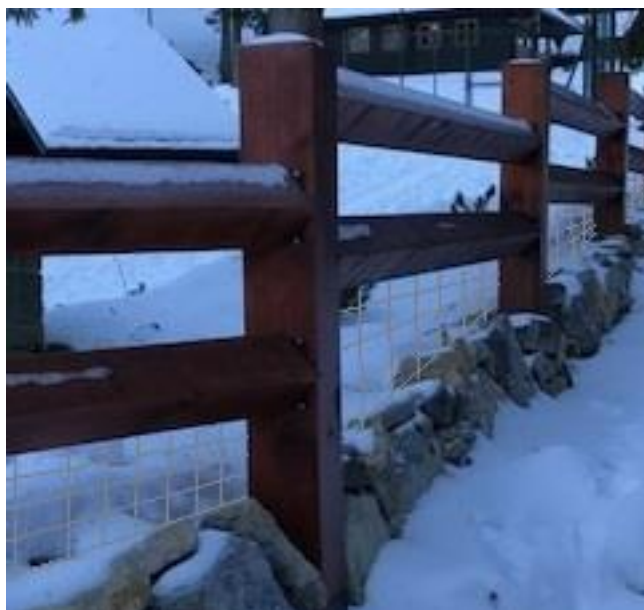
Obr.č.6. Navrhnutý tvar dreveného oplatenia v alternatíve č.2 upravený na 3 rady vodorovných hranolov.
