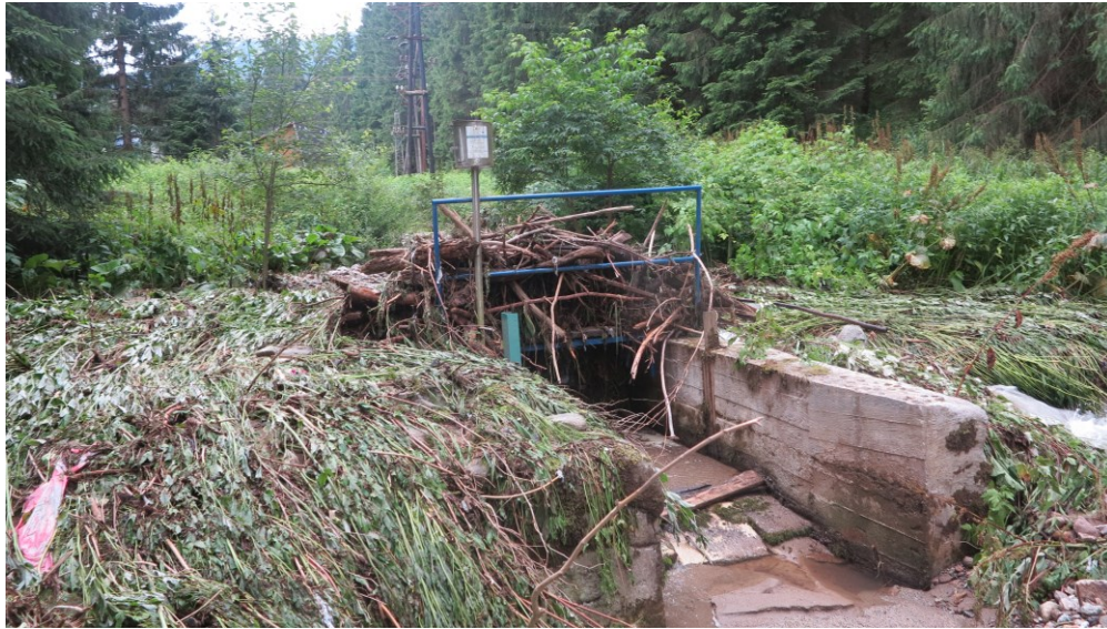
Obr. č.4. Vodomerný objekt na Priečnom potoku s obojstranným vybrežením.
