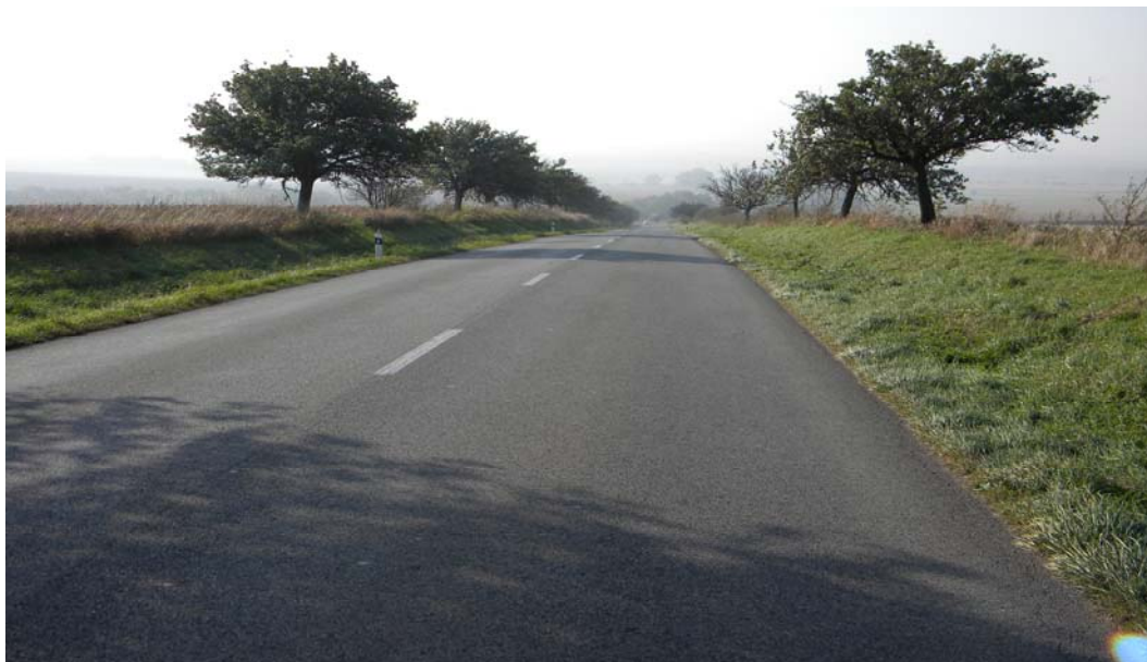
Cesta II/590 Holíč – Šaštín-Stráže
