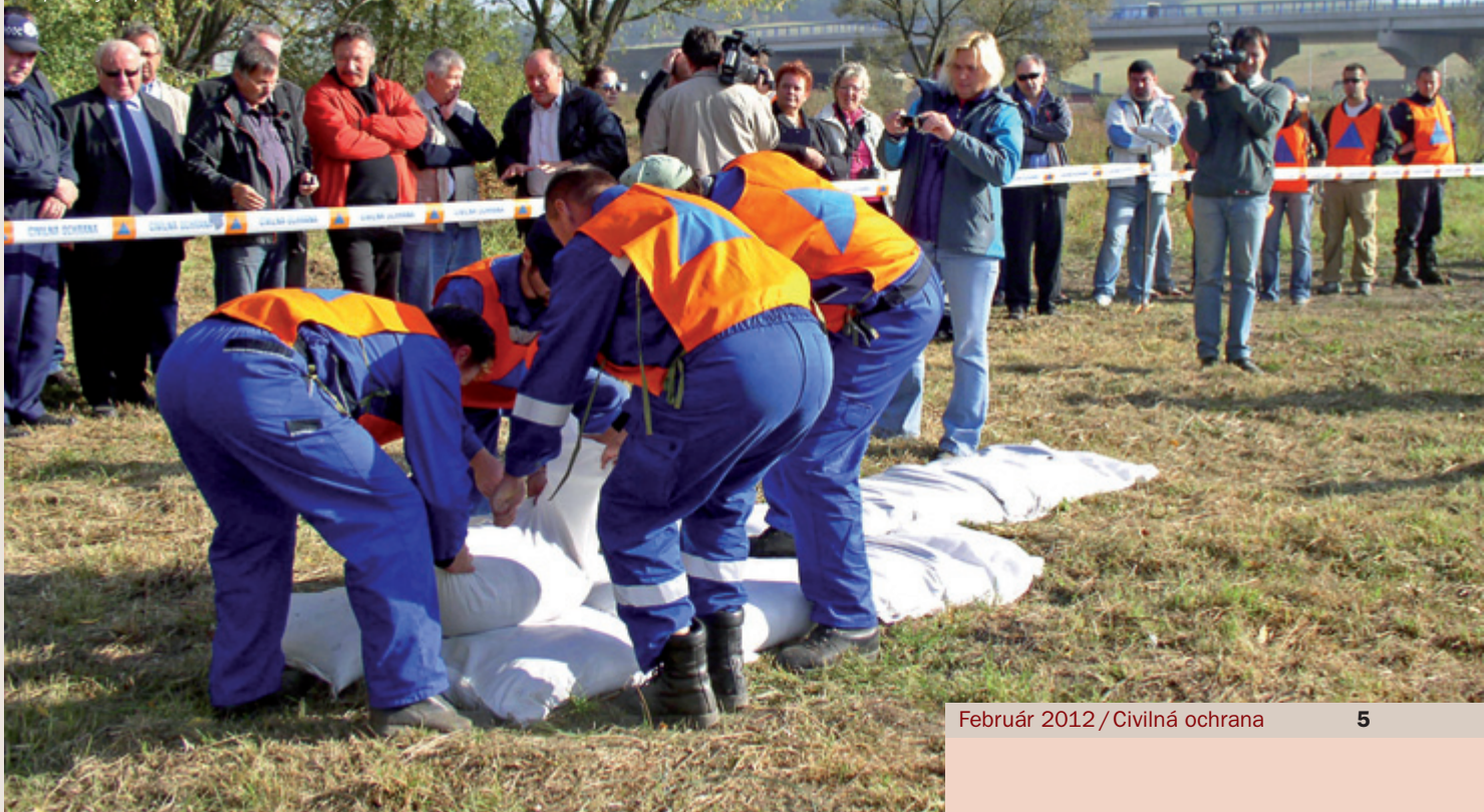
Ukážka stavby protipovodňovej steny z vriec naplnených pieskom
