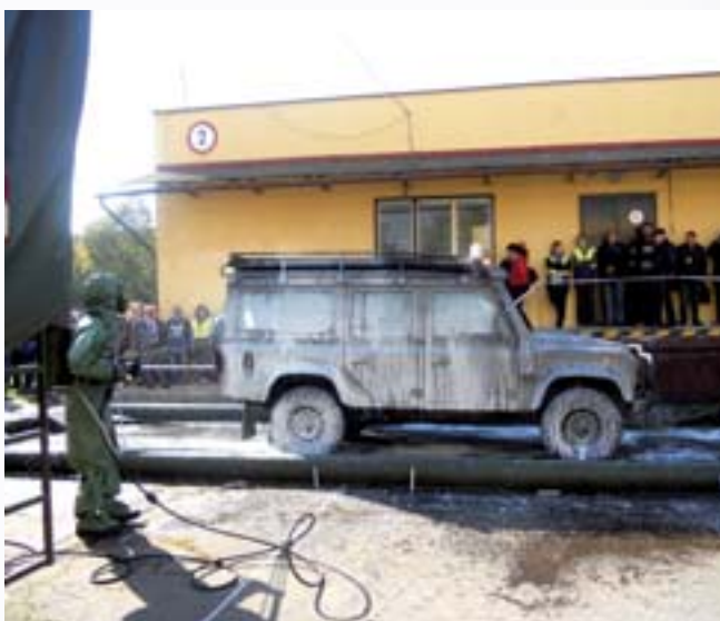
Linka na dekontamináciu vozidiel – hrubý oplach od nečistôt
