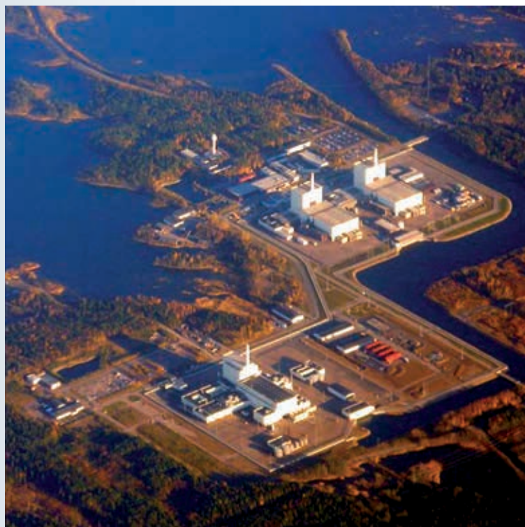
Areál atómovej elektrárne Forsmark
