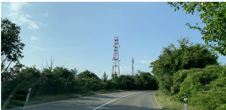
Obr. č. 4: cesta II.triedy Hlohovec – Sereď č. II/507 (C 9,5/70)
