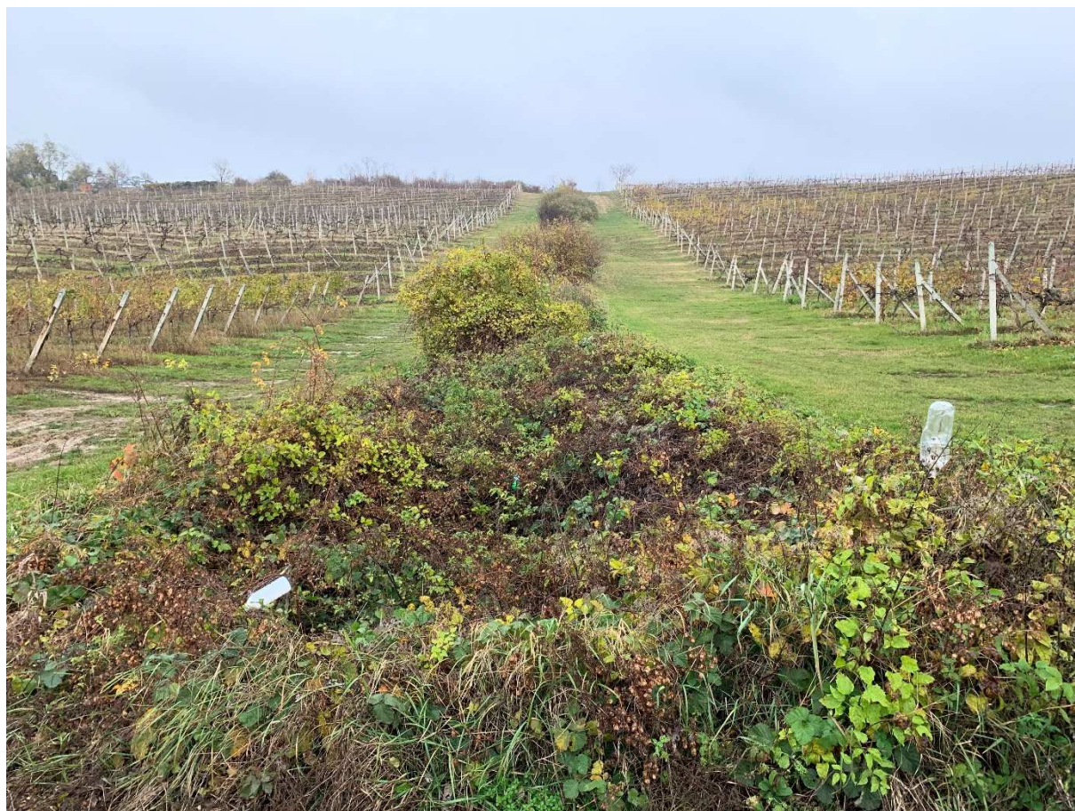
Obr. č. 15: Odvodňovací kanál OK-1
