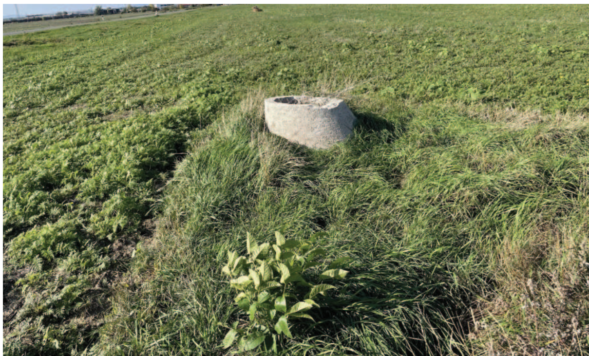
Obr. č. 13: Hydranty hydromelioračnej vetvy závlahy
