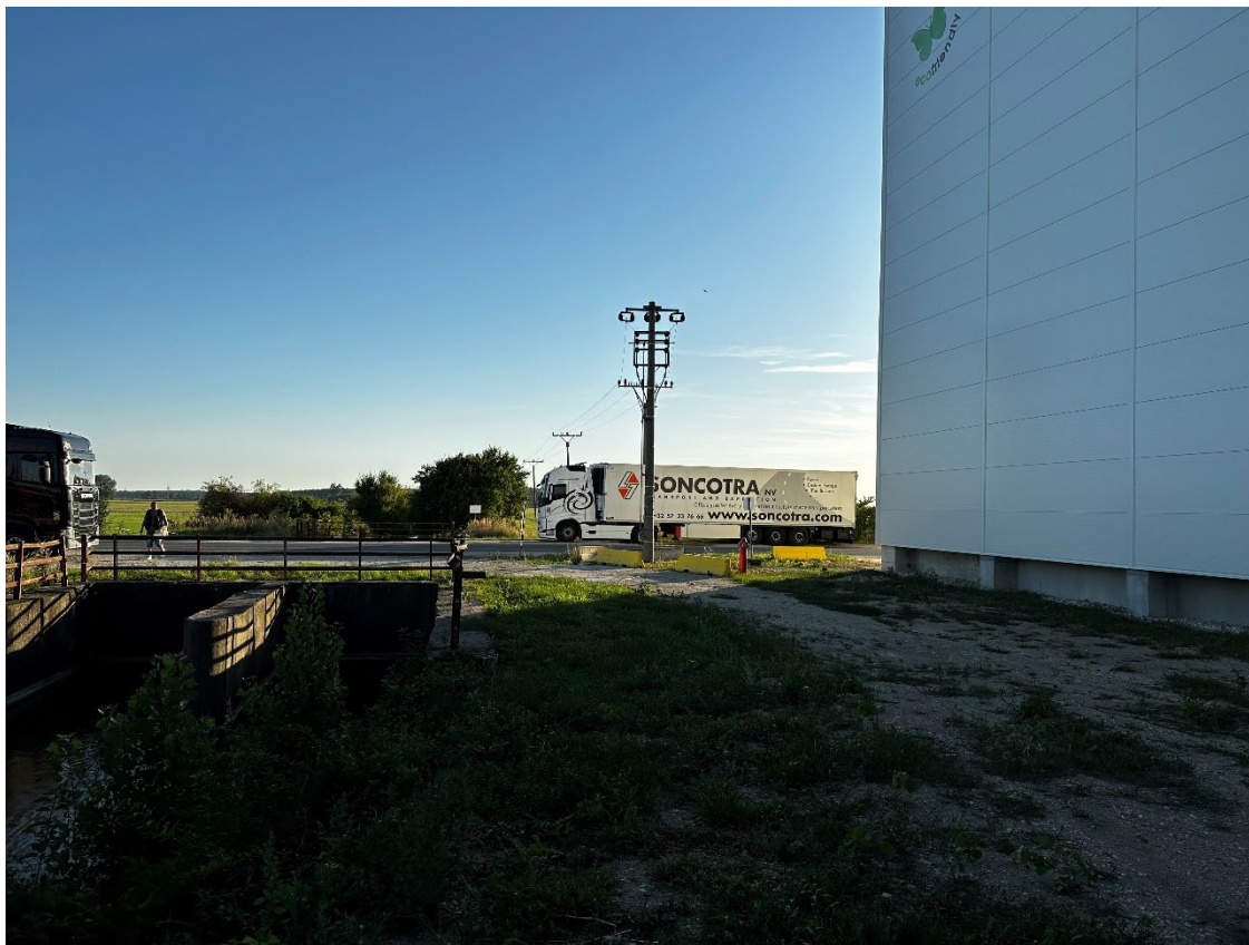
Obr. č. 11: Elektrické vzdušné vedenie 22kV s prechodom na podzemné vedenie
