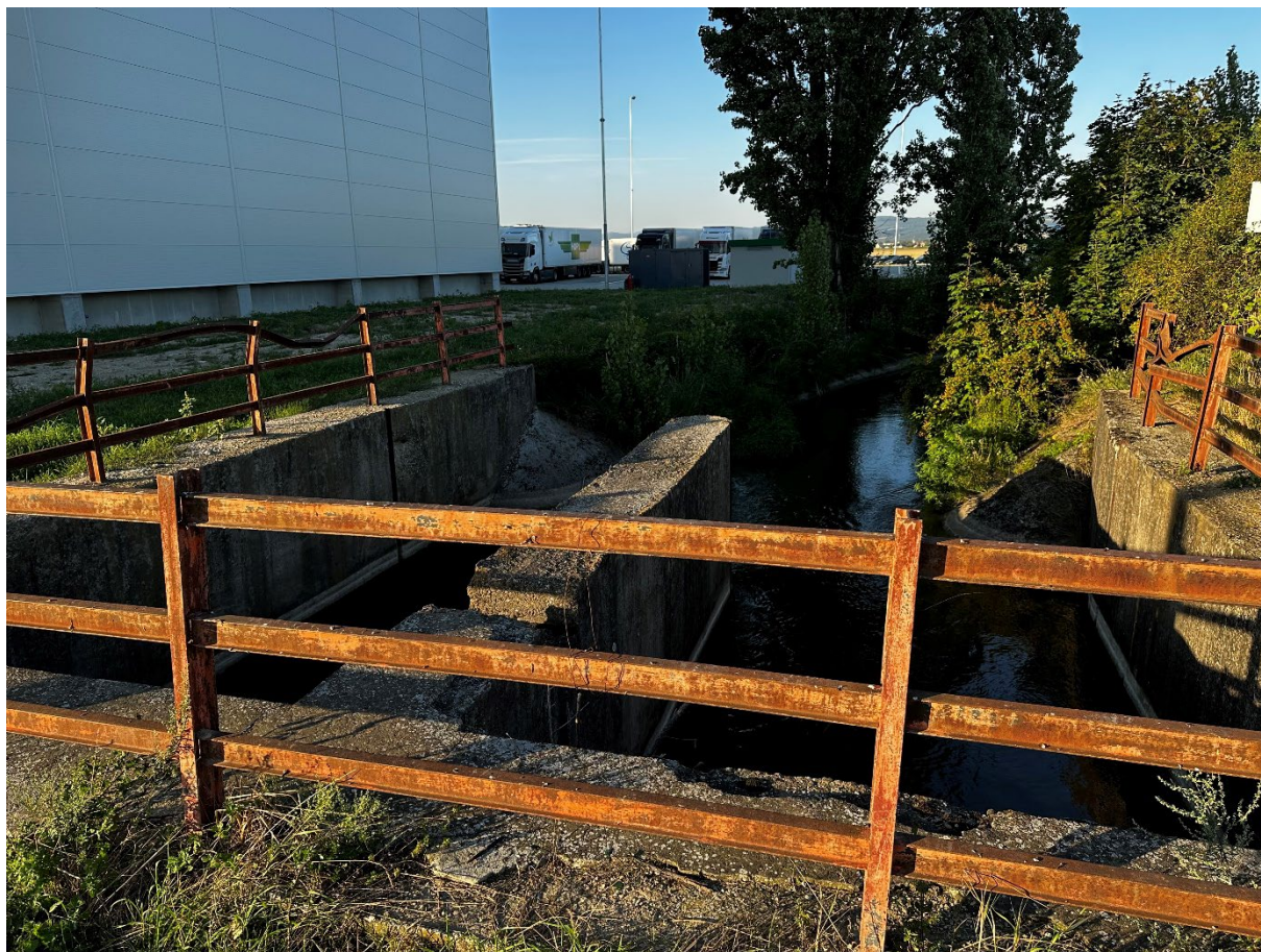
Obr. č. 10: Závlahový kanál (ZK-1) N. rekonštrukcia (evid.č.5211 175 005)
