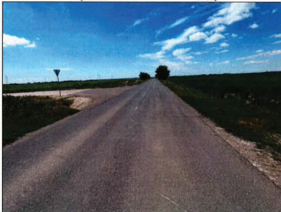
obr.3 - cesta III/1286 pohľad na smer Pavlice - Pusté Úľany
