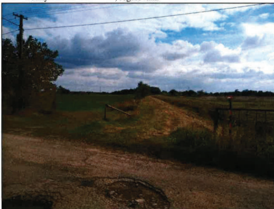
obr.2 - vodný tok Gídra - úsek 2, regulovaná časť
