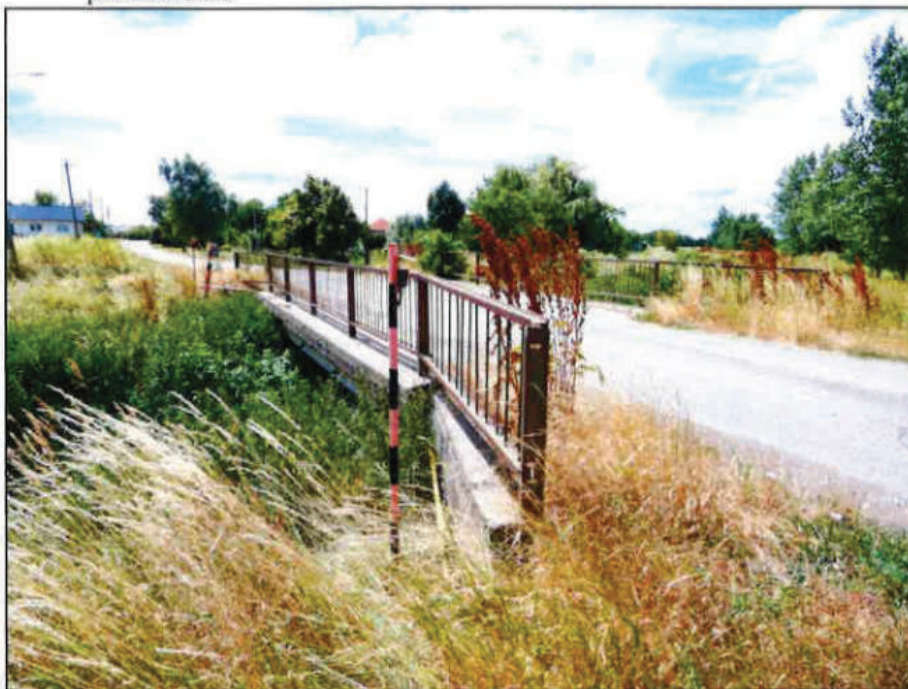
obr.3 - premostenie vodného toku Gidra - úsek 2
