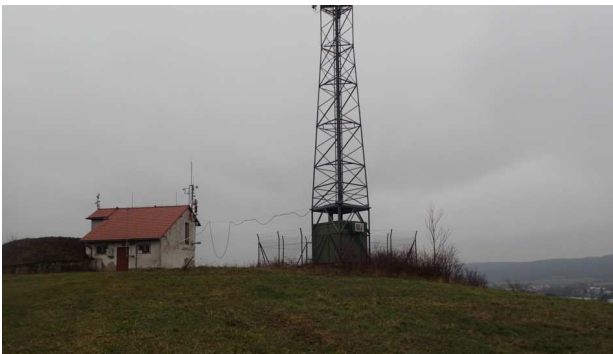
Obr.21 Vodojem nad obcou
