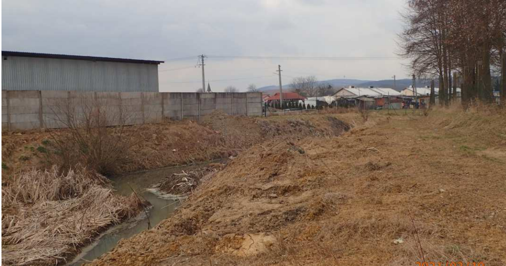
Obr. č.22 Pohľad na odvodňovaciu priekopu (PRIEK-2-6) za čističkou odpadových vôd
