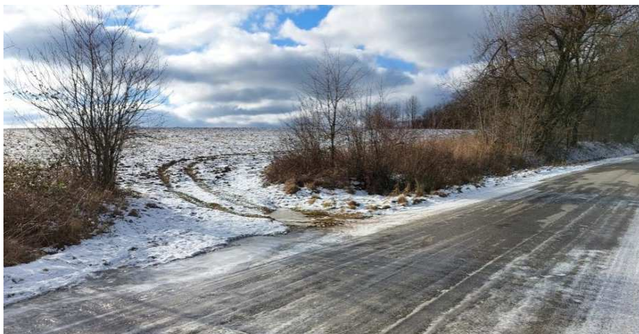
Obr.13 Hospodársky zjazd, pohľad z miestnej komunikácie na Moniku
