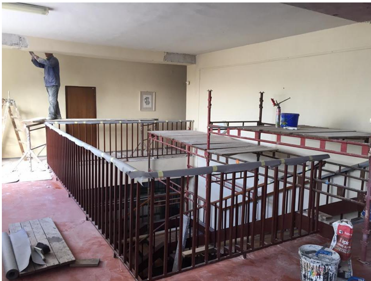
Obrázok 6: Rekonštrukčné práce v budove Štátneho archívu v Trenčíne
