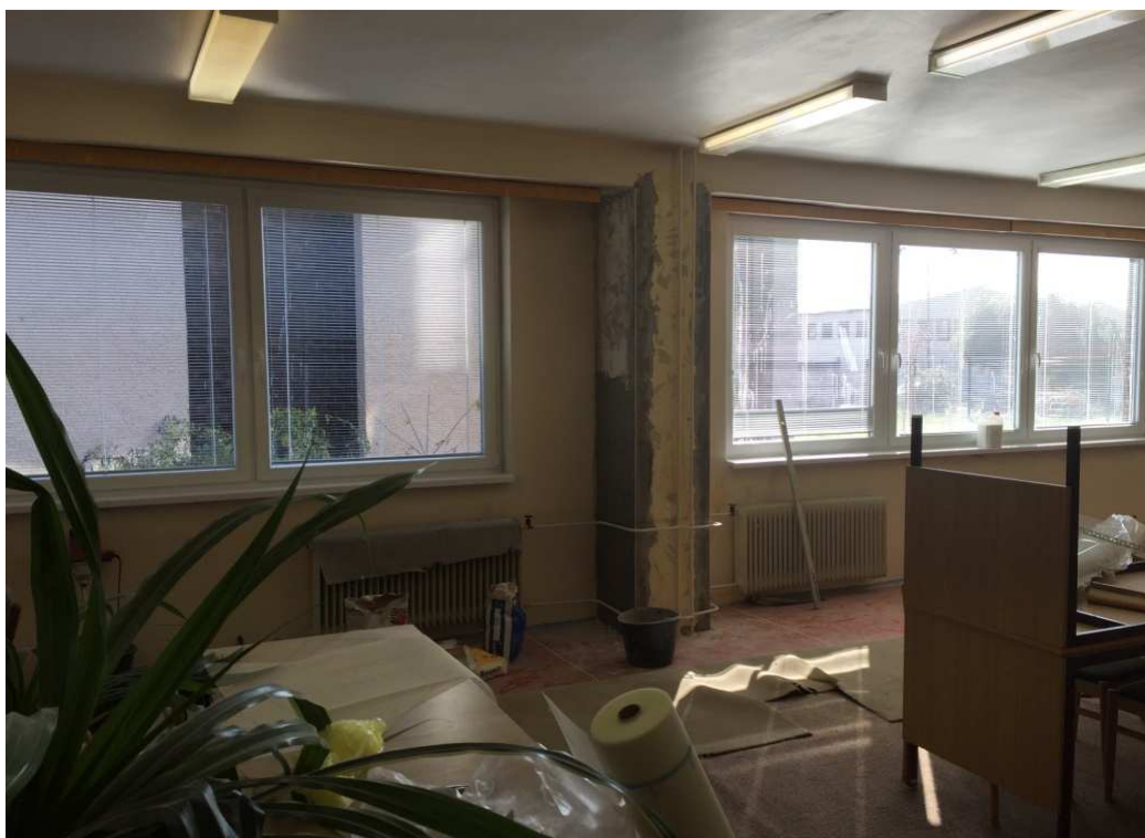
Obr. 7: Čiastočná výmena okien v budove archívu
