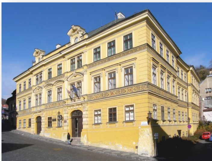
OBRÁZOK 3 – Budova bývalej Baníckej a lesníckej akadémie v súčasnosti slúži ako hlavná budova SBA v Banskej Štiavnici. Foto: SBA
