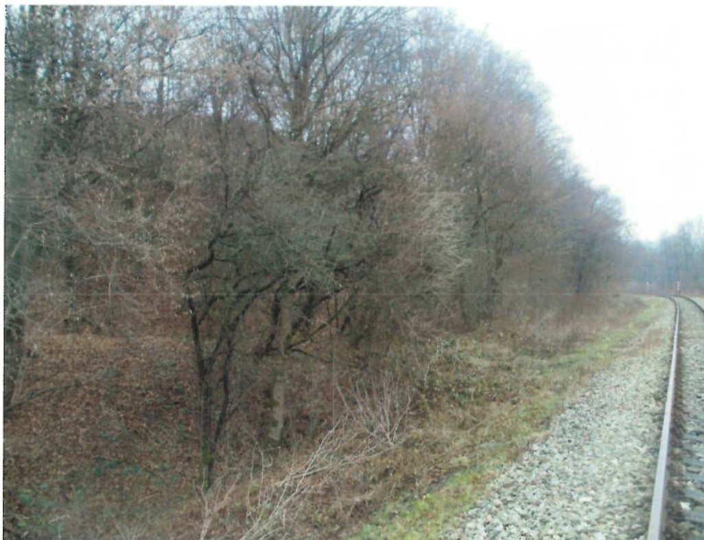
Strom č.2 – Jaseň
