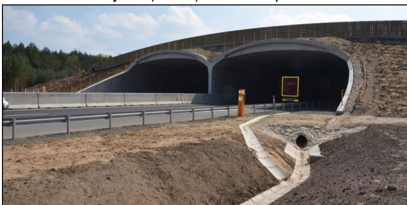
Obrázok č. 6. 8: Zelený most (ekodukt) na diaľnici D2 pri Moravskom Svätom Jáne v etape výstavby
