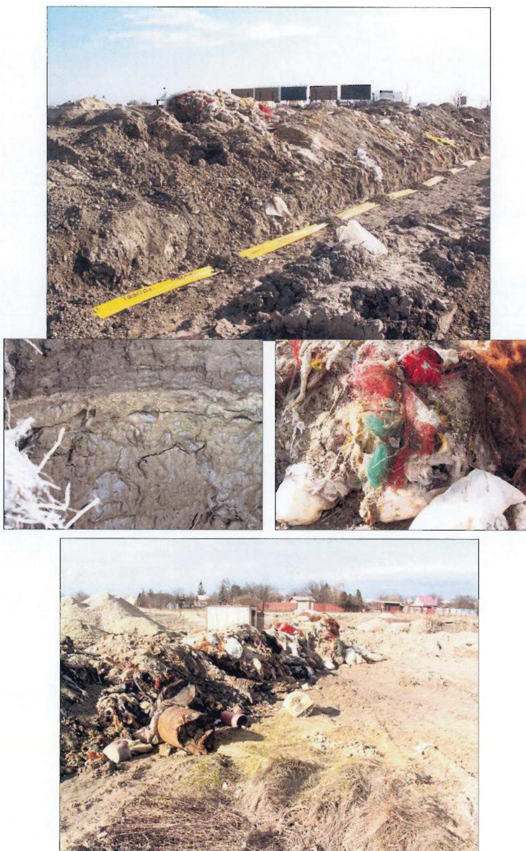
Obr. 2 Chemický odpad na lokalite environmentálnej záťaže Bratislava - Vrakuňa - Vrakunská cesta - skládka CHZJD - SK/EZ/B2/136 odkrytý v malých hĺbkach pri výkope inžinierskych sietí na ulici Pod gaštanmi.
