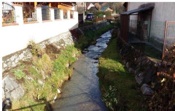
Väčšina objektov ja nadzemného charakteru. Ochranné betónové múry budú obložené lomovým kameňom. Ako alternatíva môže byť debnenie so vzorovou maticou – vzor lomový kameň. Brehy budú prevažne opevnené kamennou dlažbou opretou o betónovú pätku s obkladom z lomového kameňa. Dno potoka ostane nespevné a stabilizované betónovými prahmi a stupňami.
