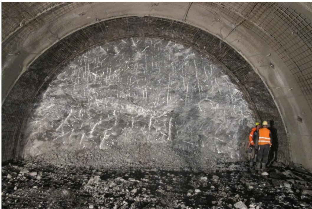
Obrázok 12 Pohľad na čelbu tunela v prostredí slienitých vápencov s preplástkami ílovcov
