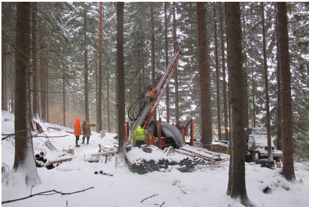
Obrázok 2 Realizácia šikmého štruktúrneho vrtu NT-17 v zimných podmienkach
