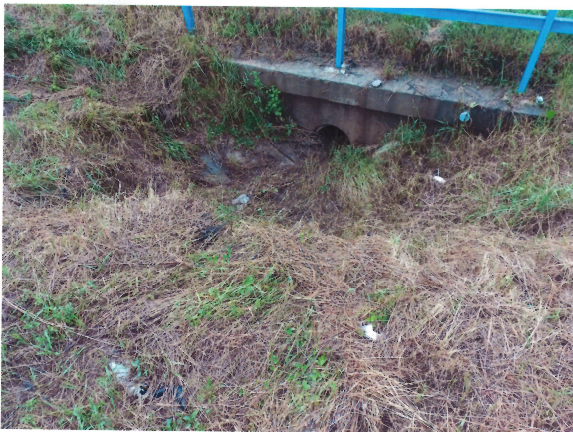
Obr. 11. Prieput s nedostatočným priemerom
