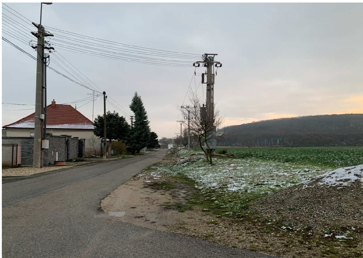
Obr. č. 15: Elektrické vedenia s trafostanicou
