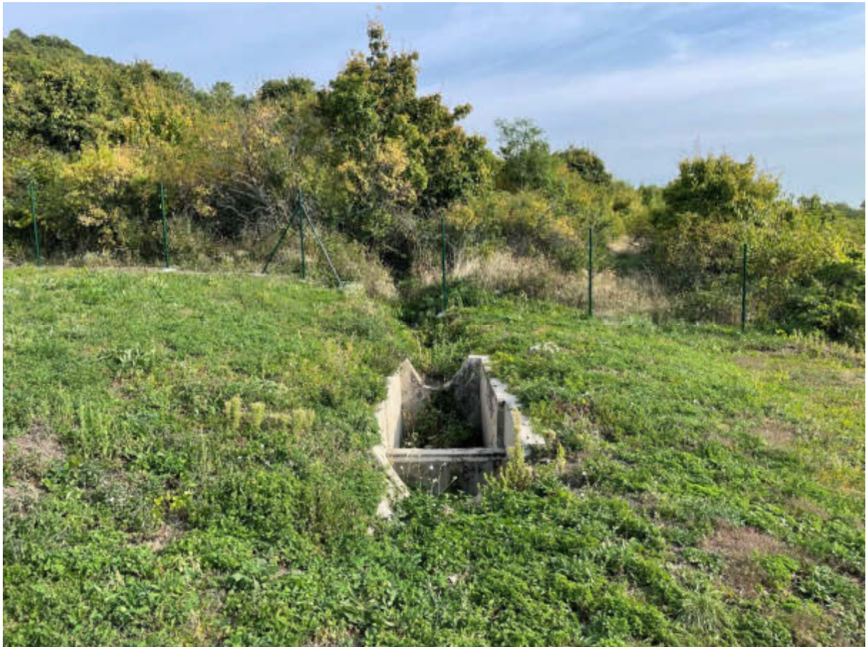
Obr. č. 17: Odvodňovací kanál OK-1
