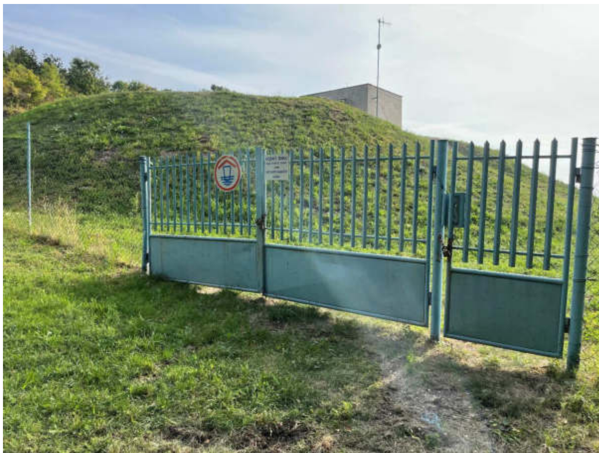
Obr. č. 23: Zemný vodojem
