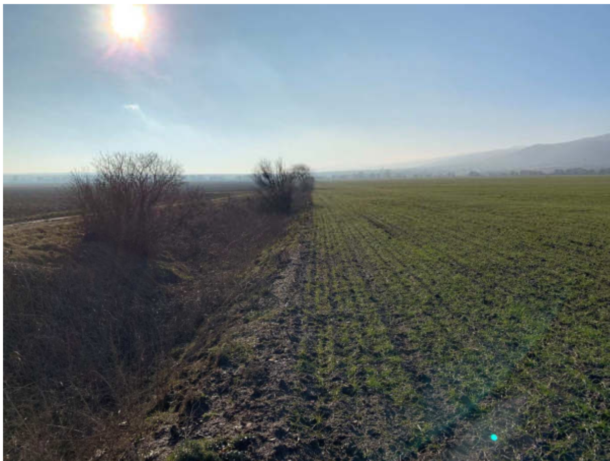
Obr. č. 18: Odvodňovací kanál OK-2
