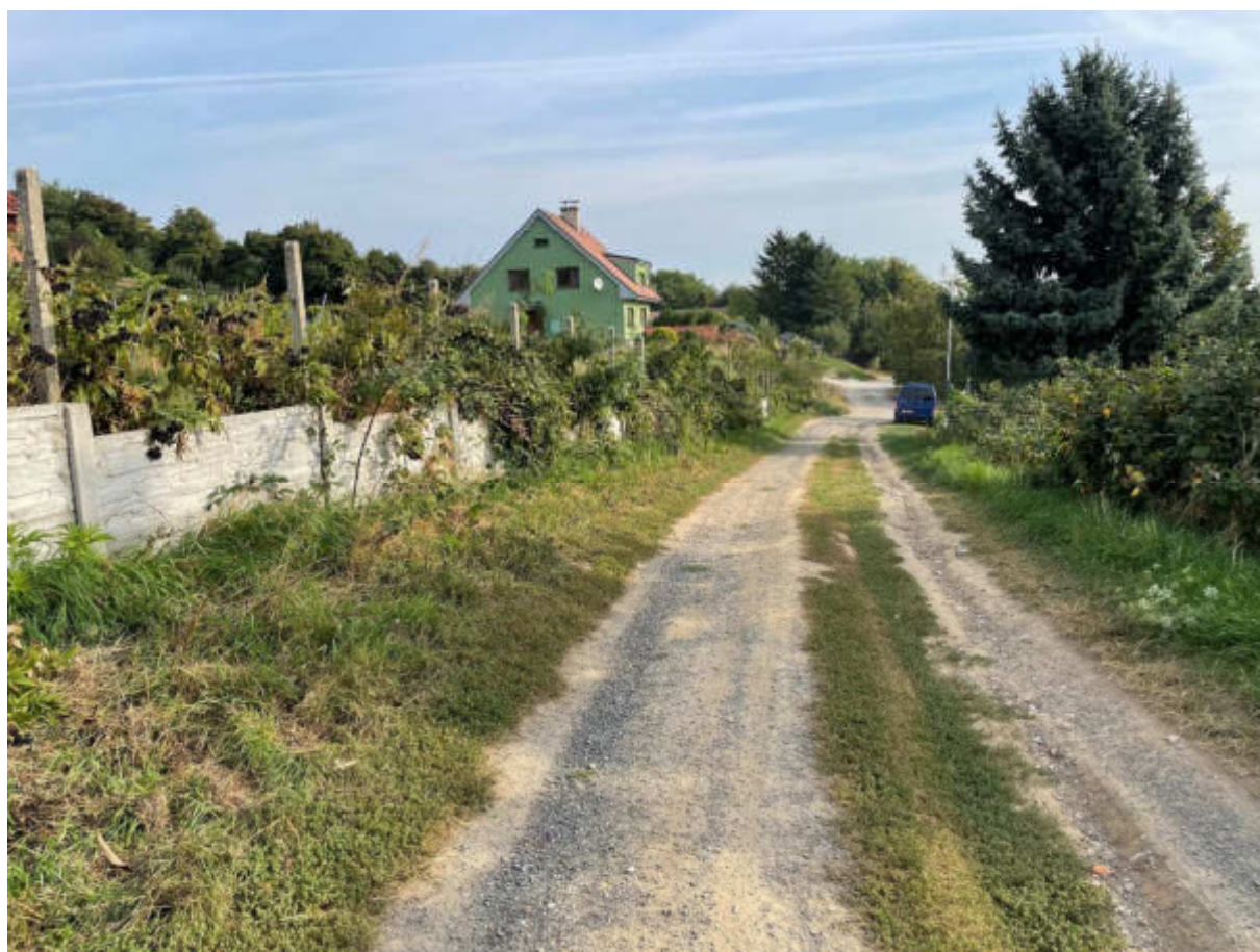
Obr. č. 6: Poľná cesta P-1 v úseku 4 obvodu
