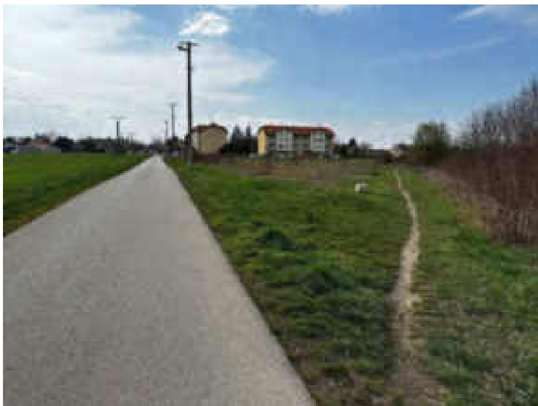
Obr. č. 18: Nadzemné elektrické vedenie NN s lampami verejného osvetlenia
