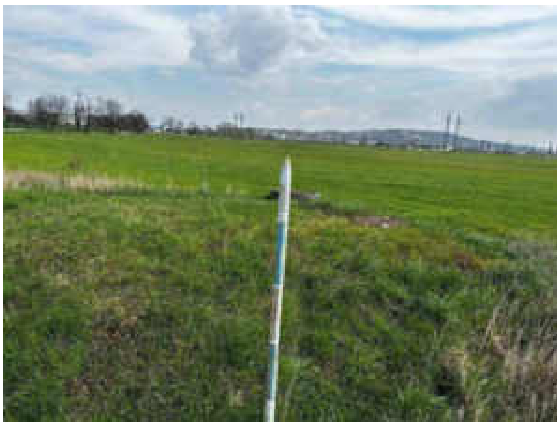
Obr. č. 16: Ochrana signalizačná tyč vodovodu DN500 s šachtou
