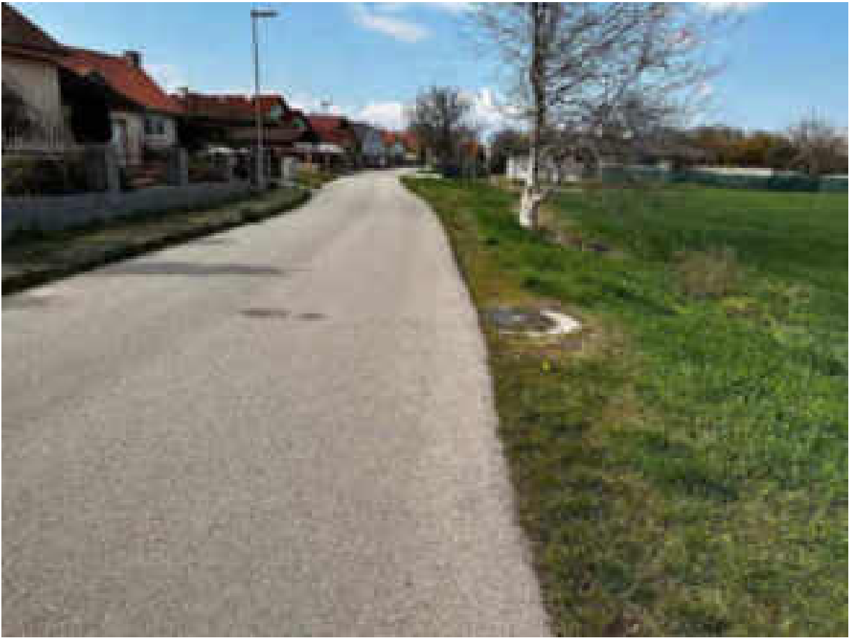
Obr. č. 14: Prípojky plynu k rodinným domom z Razusovej ulice
