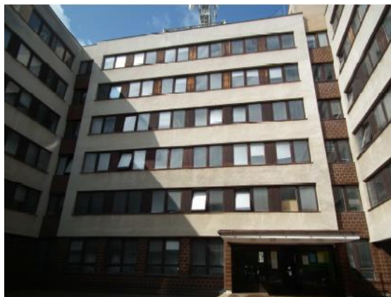
Pohľad z átria – spojovací pavilón
