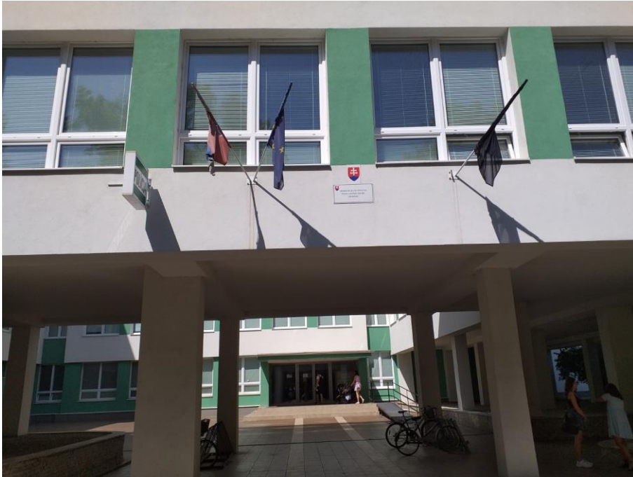
hlavná časť budovy s vchodom
