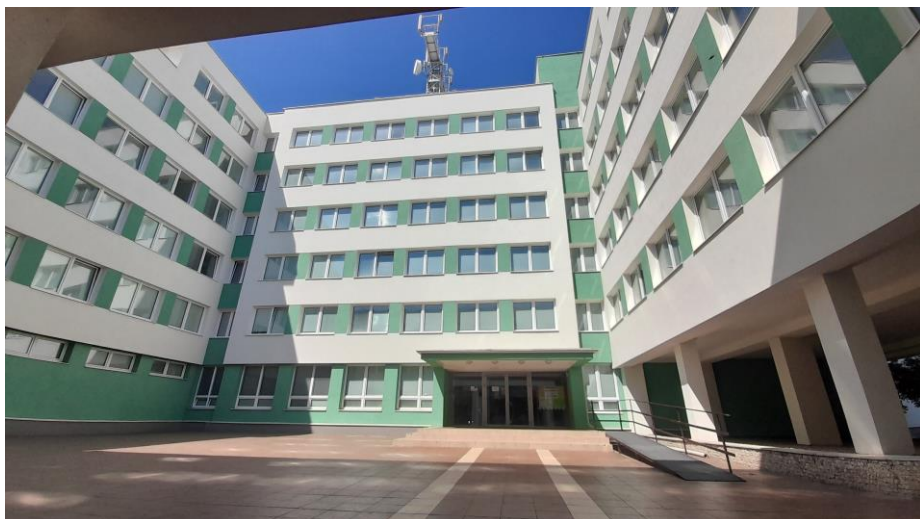
Pohľad z átria – hlavná časť budovy
