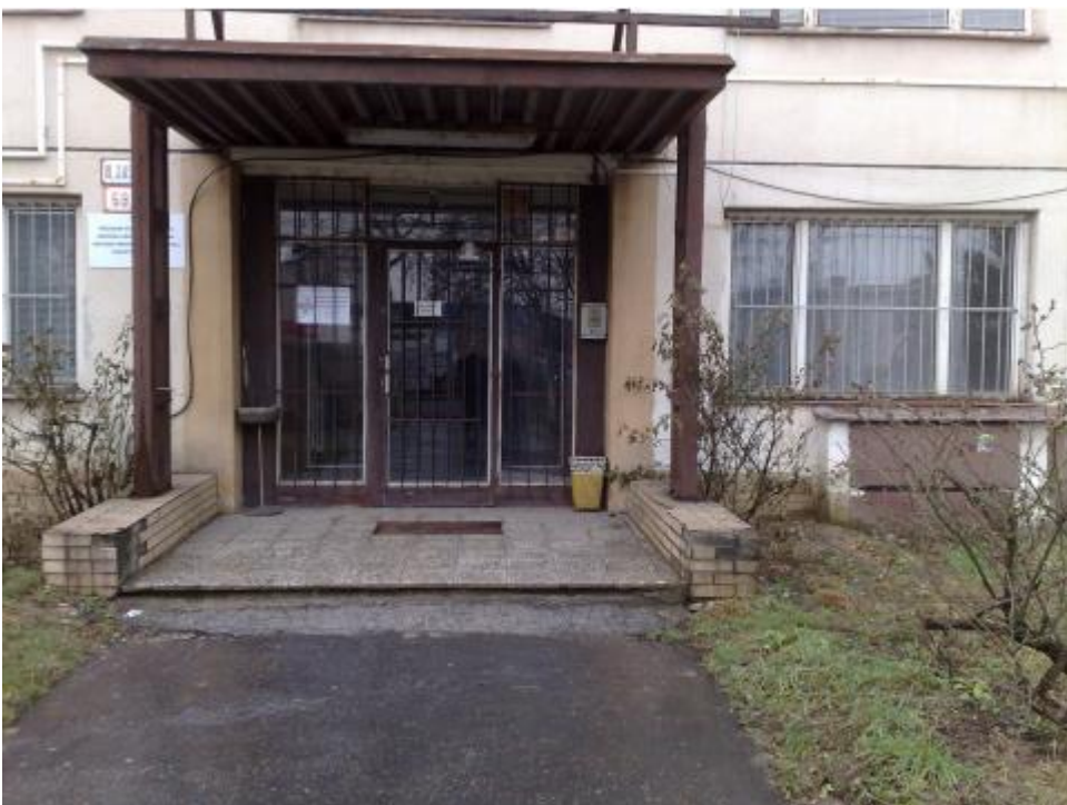
Pohľad východný – vonkajšie vchodové dvere
