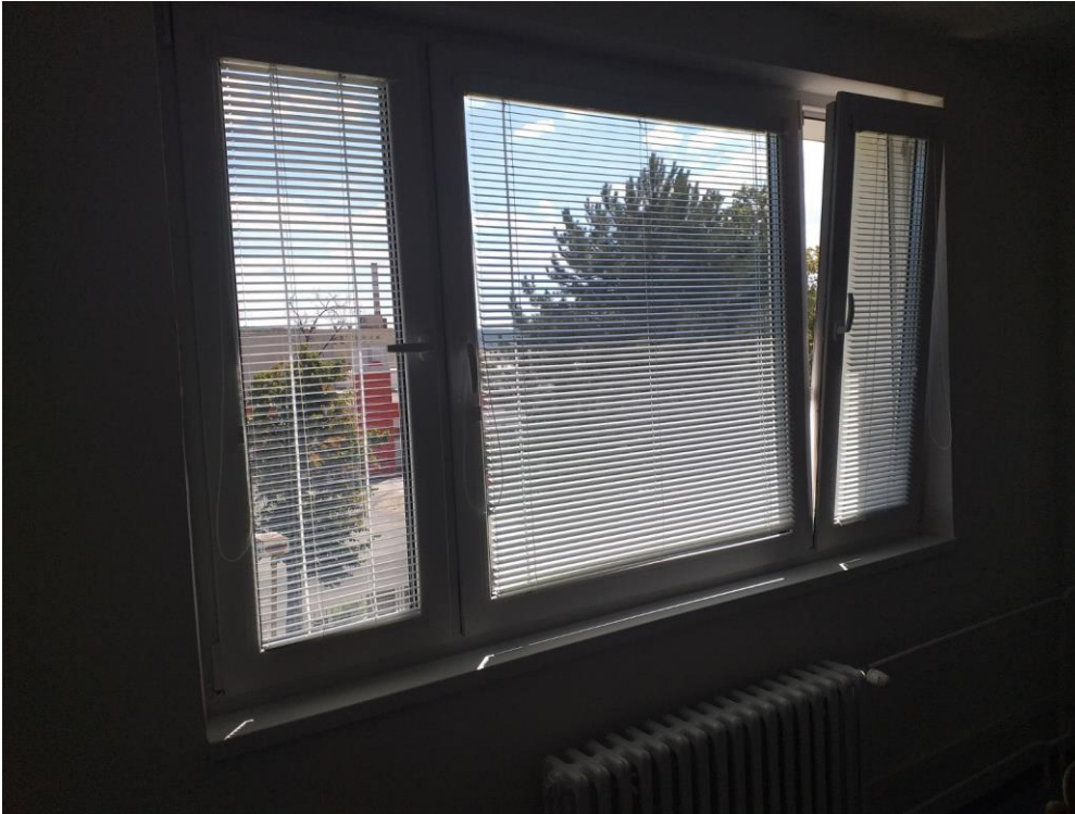
Vymenené okno – detail v interiéri
