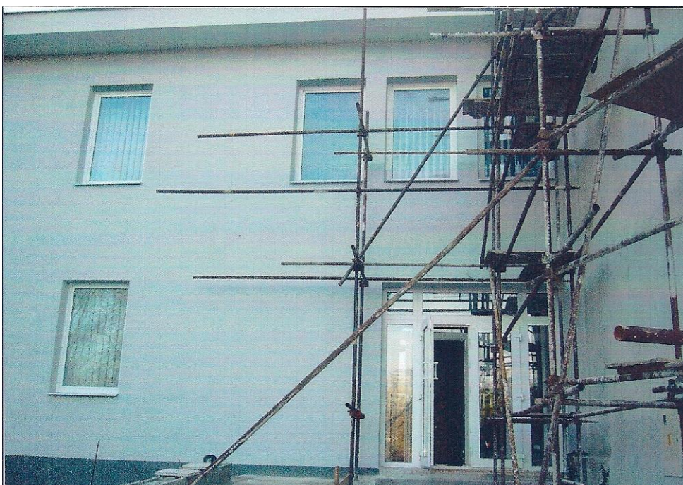
Rekonštrukcia budovy archívu
