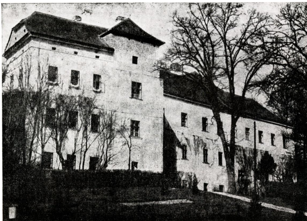
Zayovský kaštieľ v Uhrovci, kde boli v roku 1960 presťahované archívne fondy okresných archívov v Bánovciach nad Bebravou a v Topoľčanoch, následne v roku 1963
