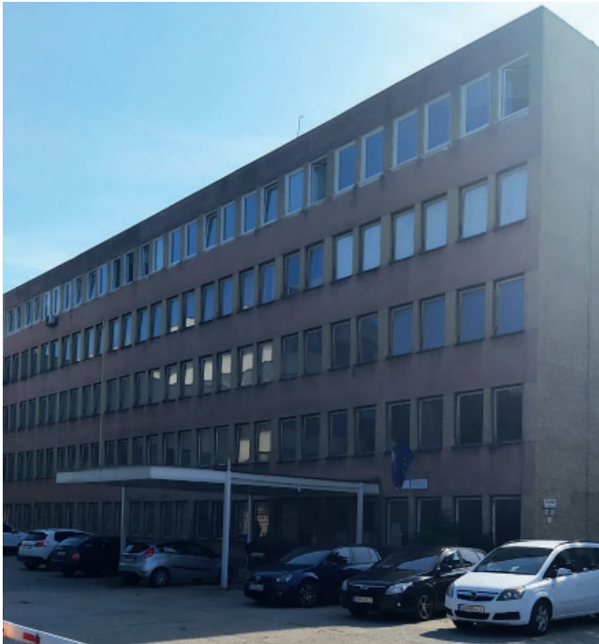
OBRÁZOK 2 – Fotografia budovy Štátneho archívu v Košiciach, pracovisko Archív Spišská Nová Ves na ulici Markušovská cesta č. 1, kde sídli od roku 2020. Foto: Autor.
