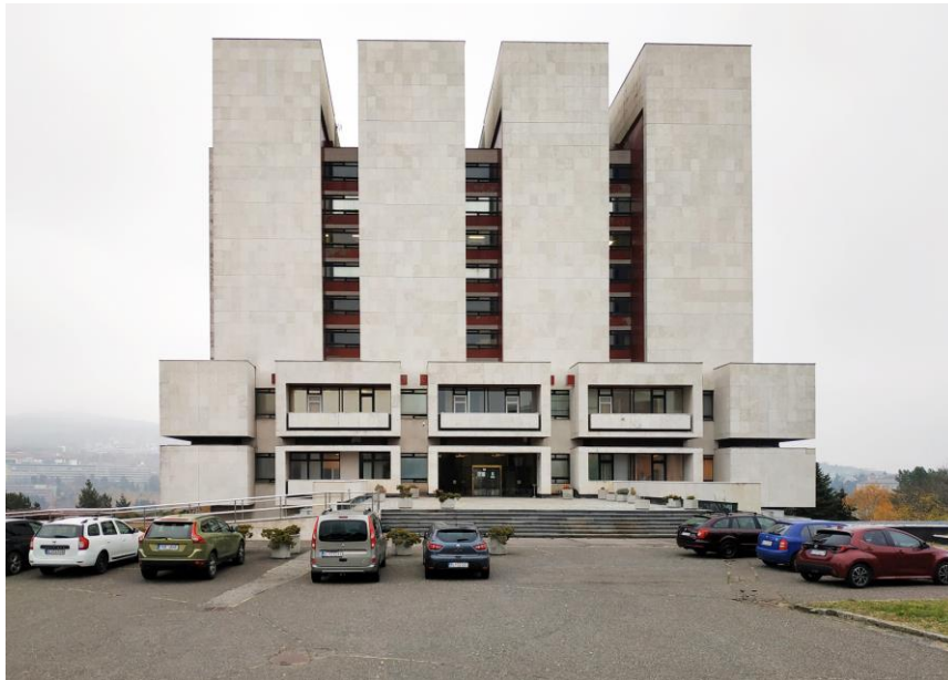
Budova Slovenského národného archívu Drotárska cesta č. 42, Bratislava. Foto: Peter Pekár
