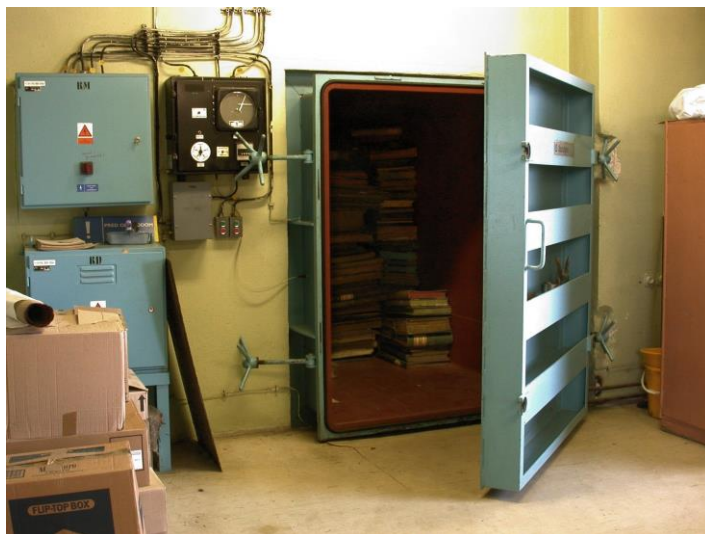
Dlhé roky nefunkčná etylénoxidová komora. Foto: Peter Pekár
