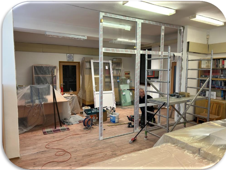
Inštalácia presklenej steny v bádateľni sídelného archívu
