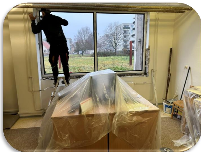
Výmena okien v sídelnom archíve
